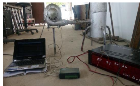
Gambar.3 Instalasi Alat Ukur.
